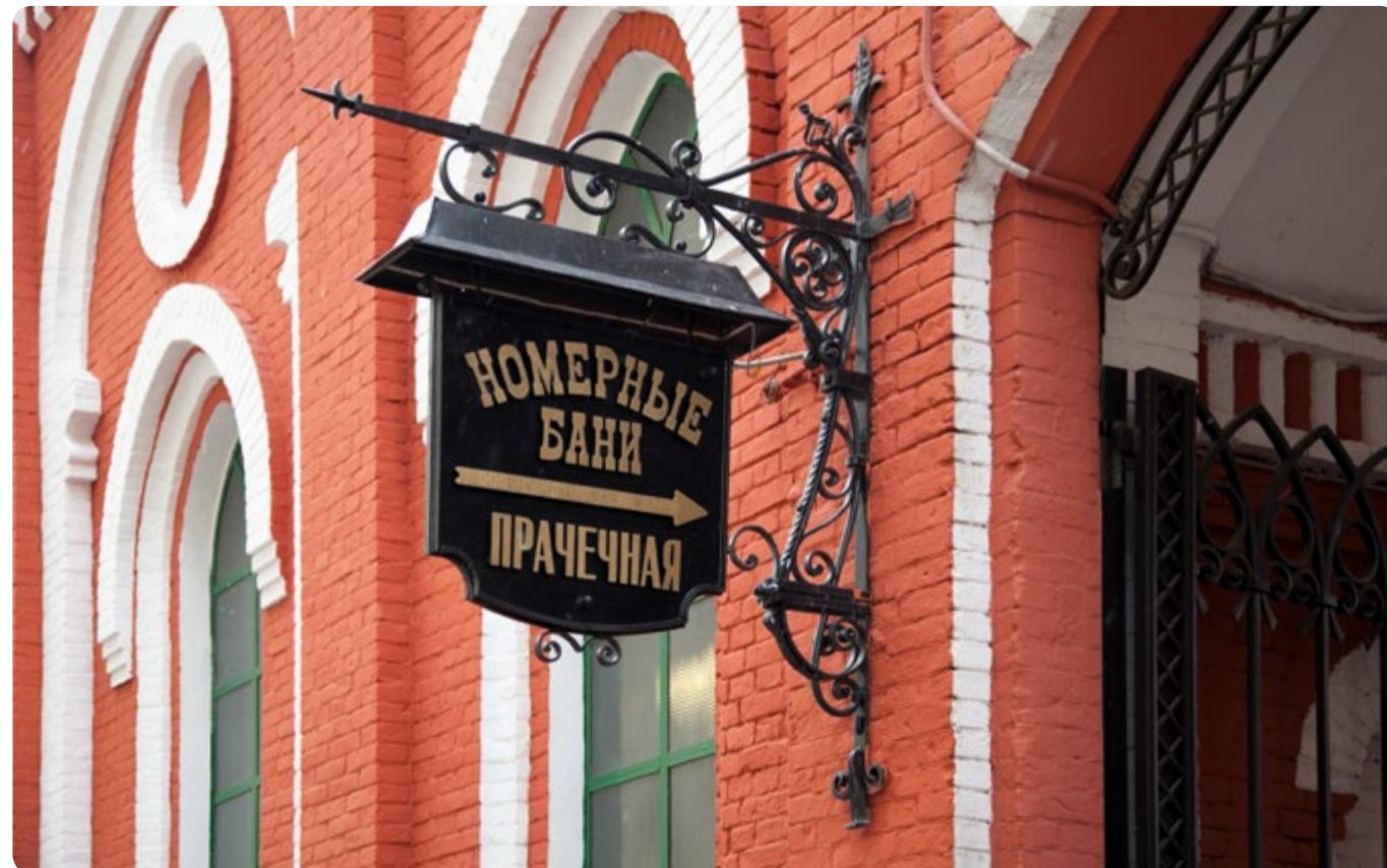
Рис. 2-51. Консольная вывеска соответствует облику здания и размещена в пределах помещения ее владельца. Крепление вывески является активным элементом дизайна, элементы крепежа не видны
