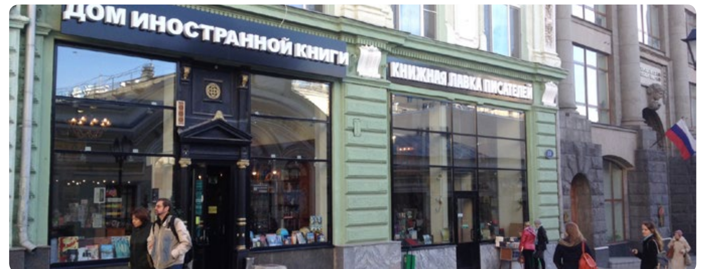
Рис. 2-23. Лучше: однотипные вывески на подложке одного цвета установлены на одинаковой высоте с учетом архитектурных элементов фасада
