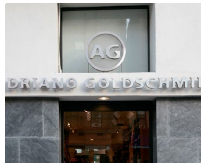
Рис. 2-12. Объемные буквы отнесены от стены
