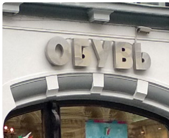
Рис. 2-11. Объемные буквы вплотную к стене
