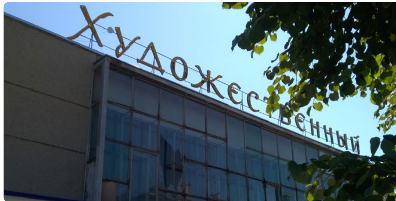
Рис. 2-74. Вывеска из отдельно стоящих объемных букв на крыше кинотеатра
