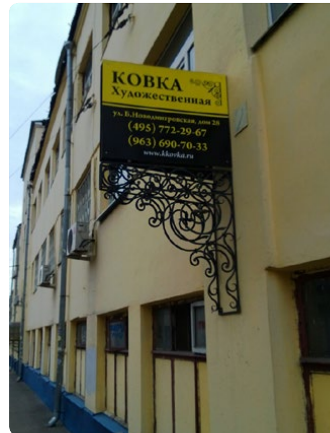
Рис. 2-52. Декорированная консоль не соответствует облику здания
