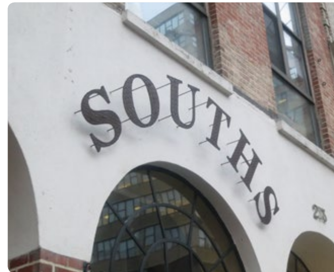
Рис. 2-10. Плоские буквы отнесены от стены
