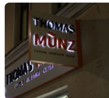
Рис. 4-24. Буквы с контражурным подсветом на консольной вывеске
