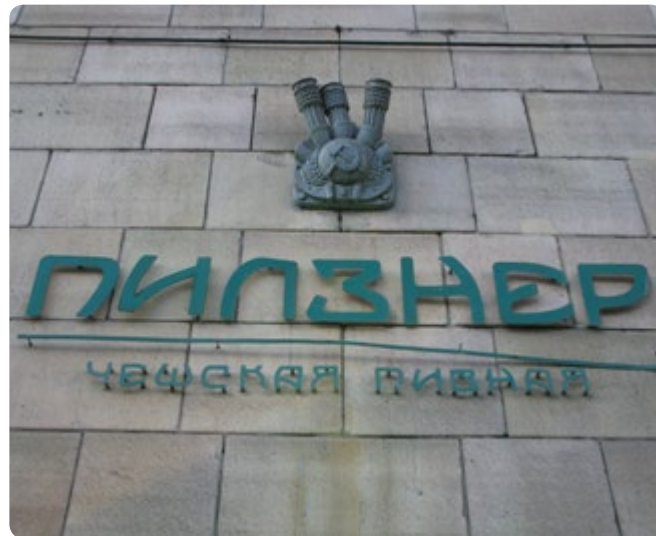
Рис. 2-9. Плоские буквы вплотную к стене
