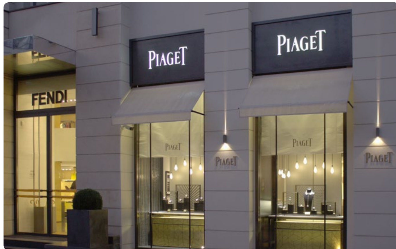
Рис. 2-28. Световые короба выровнены по ширине оконных проемов
