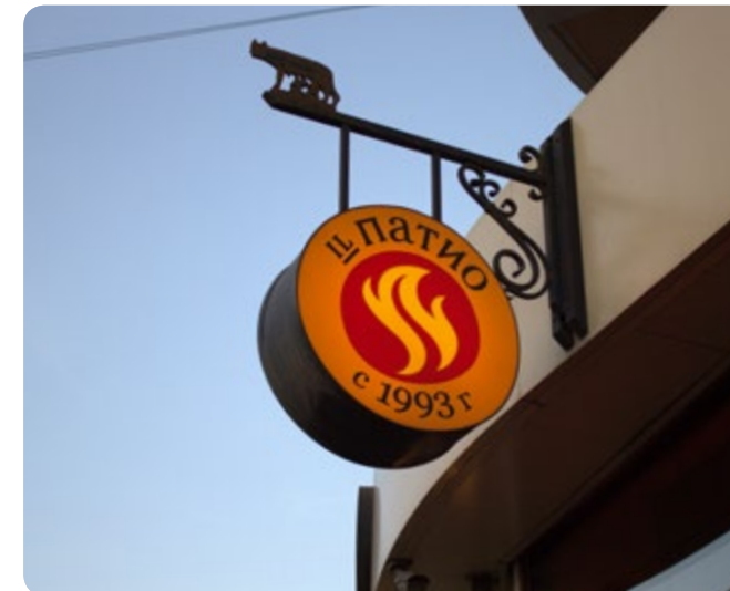
Рис. 2-47. Световой короб на ажурном кронштейне
