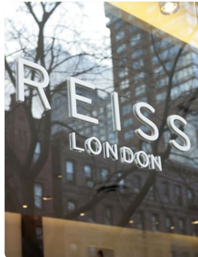
Рис. 2-54. Отдельные буквы без подложки на внешней стороне остекления витрины
