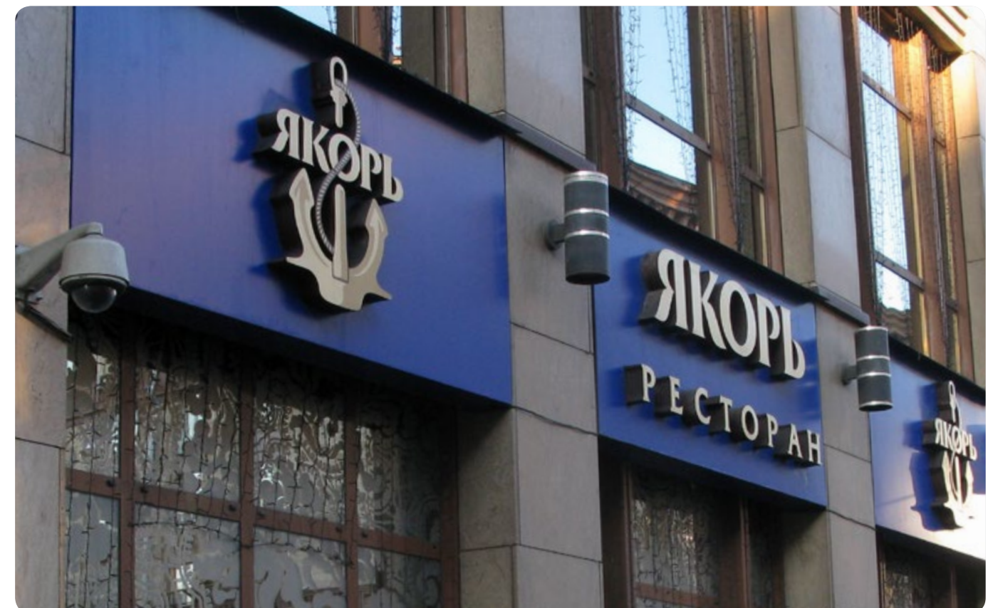
Рис. 2-18. Объемные буквы на подложке вплотную к фасаду
